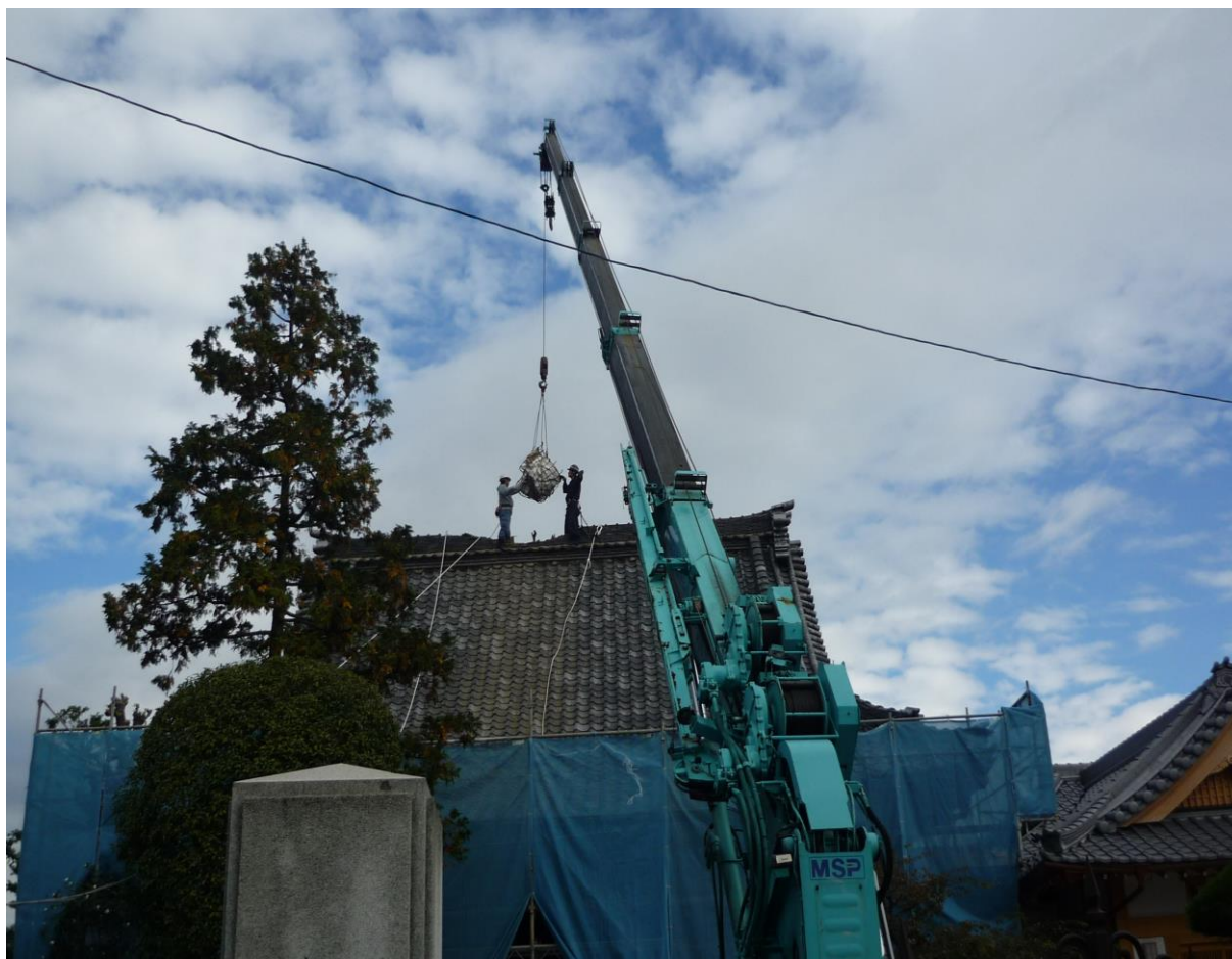
平成二十二年度本堂改修工事の様子（平成二十二年二十三号） 瓦の撤去 改修開始 風景
