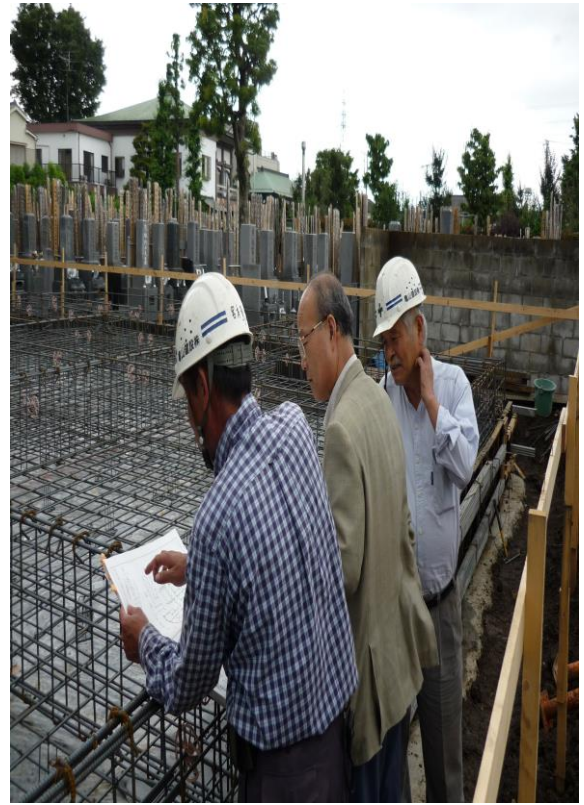
基礎コンクリー打ち検査
