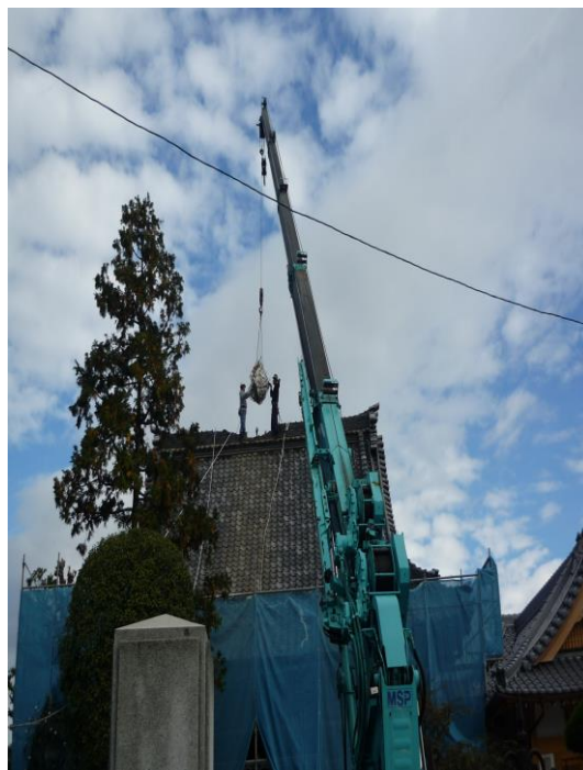
解体工事 平成21年11月
