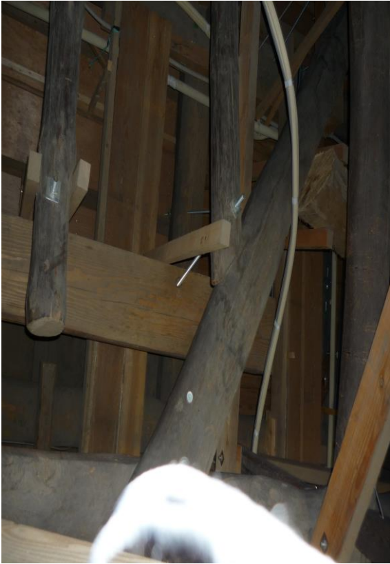
「屋根小屋東側 妻壁裏側」
