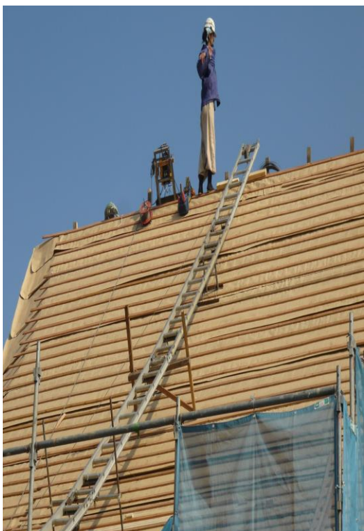
④ 「シートを止め、瓦の下地板施工が完成した」
