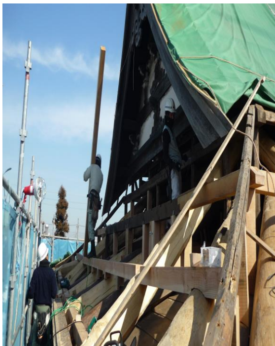
屋根小屋・軒先補強 平成21年12月・平成22年1月
