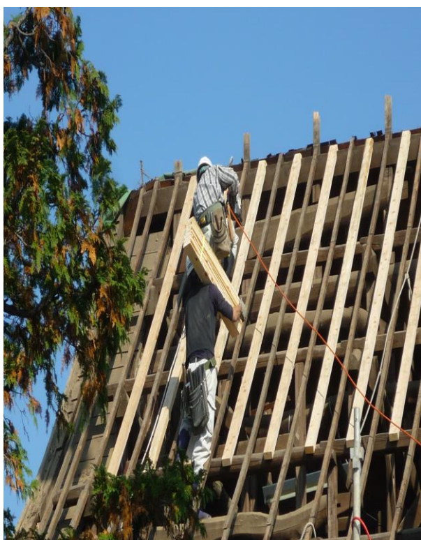
① 「下地板を貼る準備、新しい板を骨組みに追加している様子」
