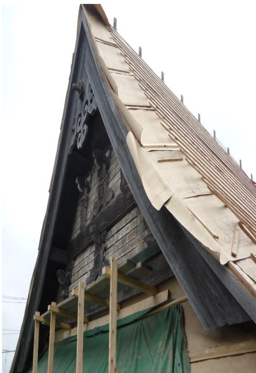
③ 「瓦の下地板の上にシートを張り、防水している」
