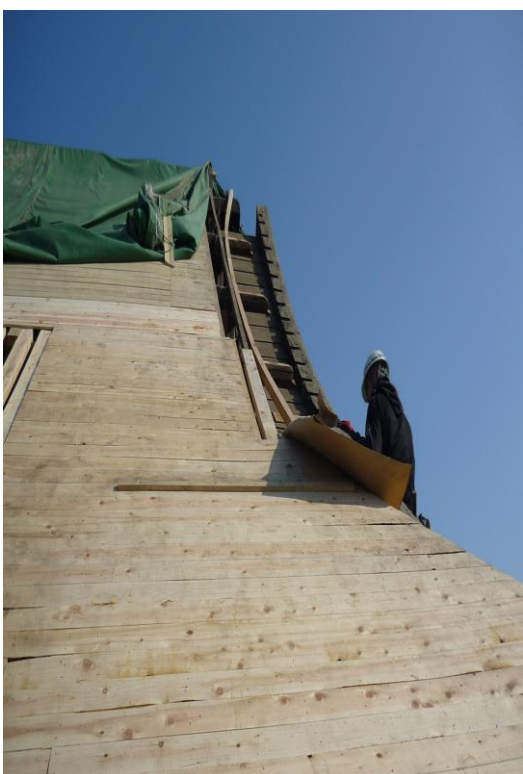
② 「新しい下地板が張られた状況」
